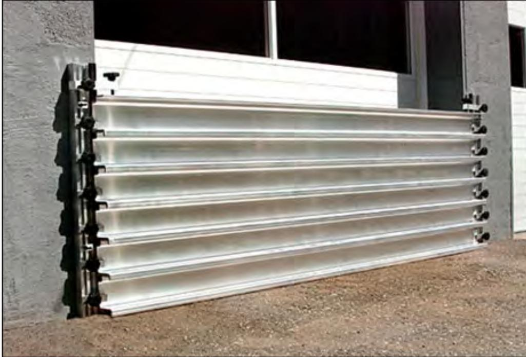
**Figura 10: Ejemplo de impermeabilización en seco**
