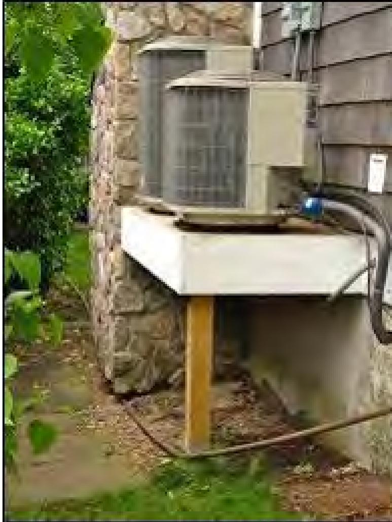
**Figura 9: Ejemplo de impermeabilización húmeda**
